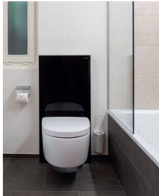
NACHHER Einbausituation mit Geberit Monolith
